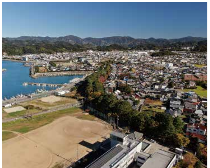
写真1 国史跡 広村堤防 現在も防潮堤としての役割を果たしています。
