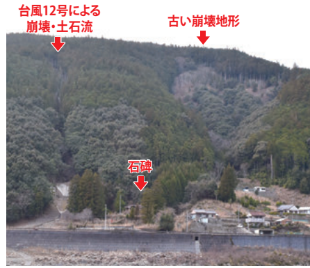
写真6 九重の土石流発生場所・北隣の沢筋・石碑の場所(平成30年1月9日撮影)
