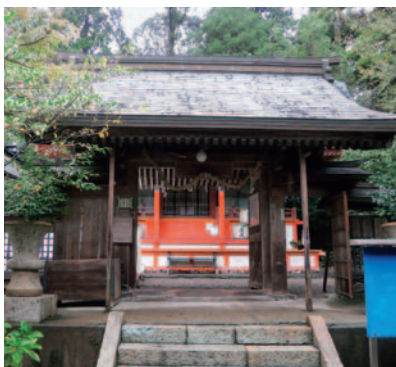
写真1 現在の十三神社 奥の朱色の建物が本殿
