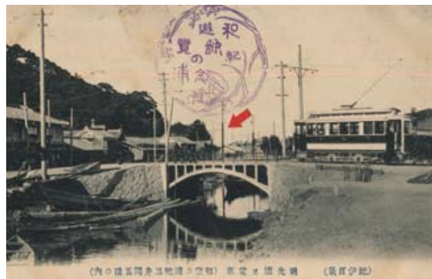
⑦明光橋西詰めの和歌の浦停留所
