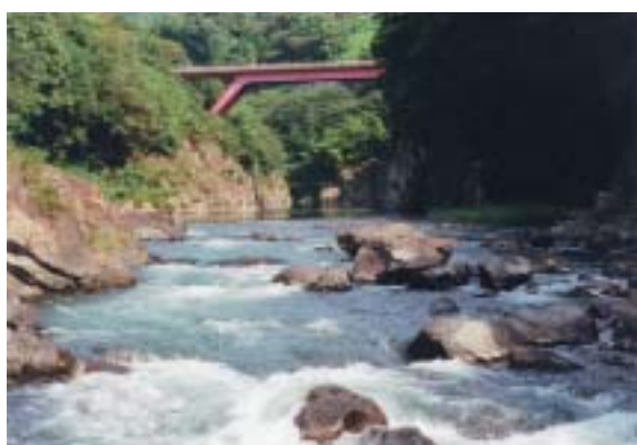
松原橋と小瀧の現況
