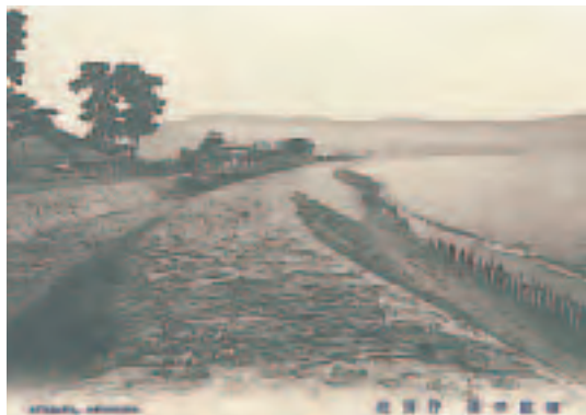
図 石張堤防の背後は越波排水路のようになっています
