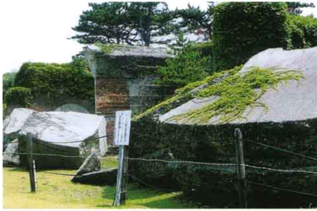
第2砲台（爆破された胸牆）
