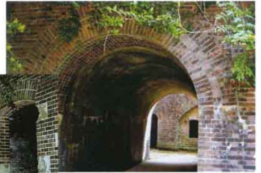
将校宿舍側より弾薬庫側への入口▲
