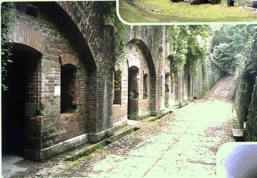
▲友ヶ島第3砲台 (後方通路と弾薬庫)
