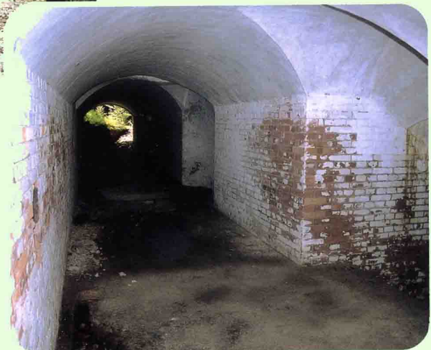
友ヶ島第4砲台▶ (砲座間の地下道)
