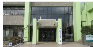
新宮市役所 庁舎別館
