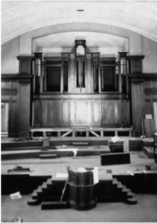
写真⑩「大風琴配管前ノ外枠工事」
